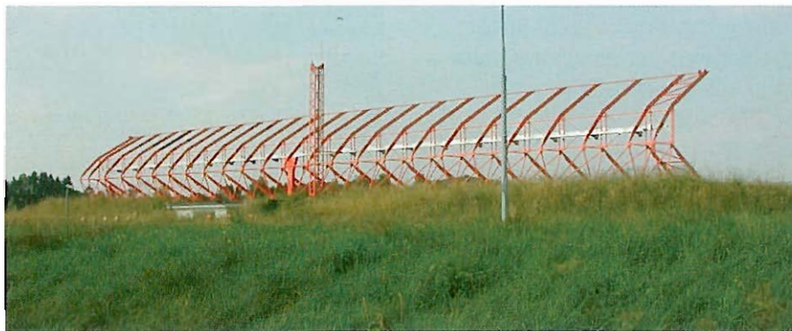
Radiofaro direzionale (ILS) situato ai bordi della pista di atterraggio per orientare gli aerei tramite le onde hertziane.
