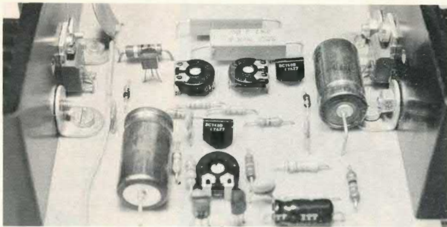
Al centro dell'immagine i trimmer di taratura: è sempre necessario regolare la corrente di riposo ed il circuito limitatore di picco. I collegamenti fra stadio finale e circuiti d'ingresso devono obbligatoriamente avvenire con cavetti schermati.
