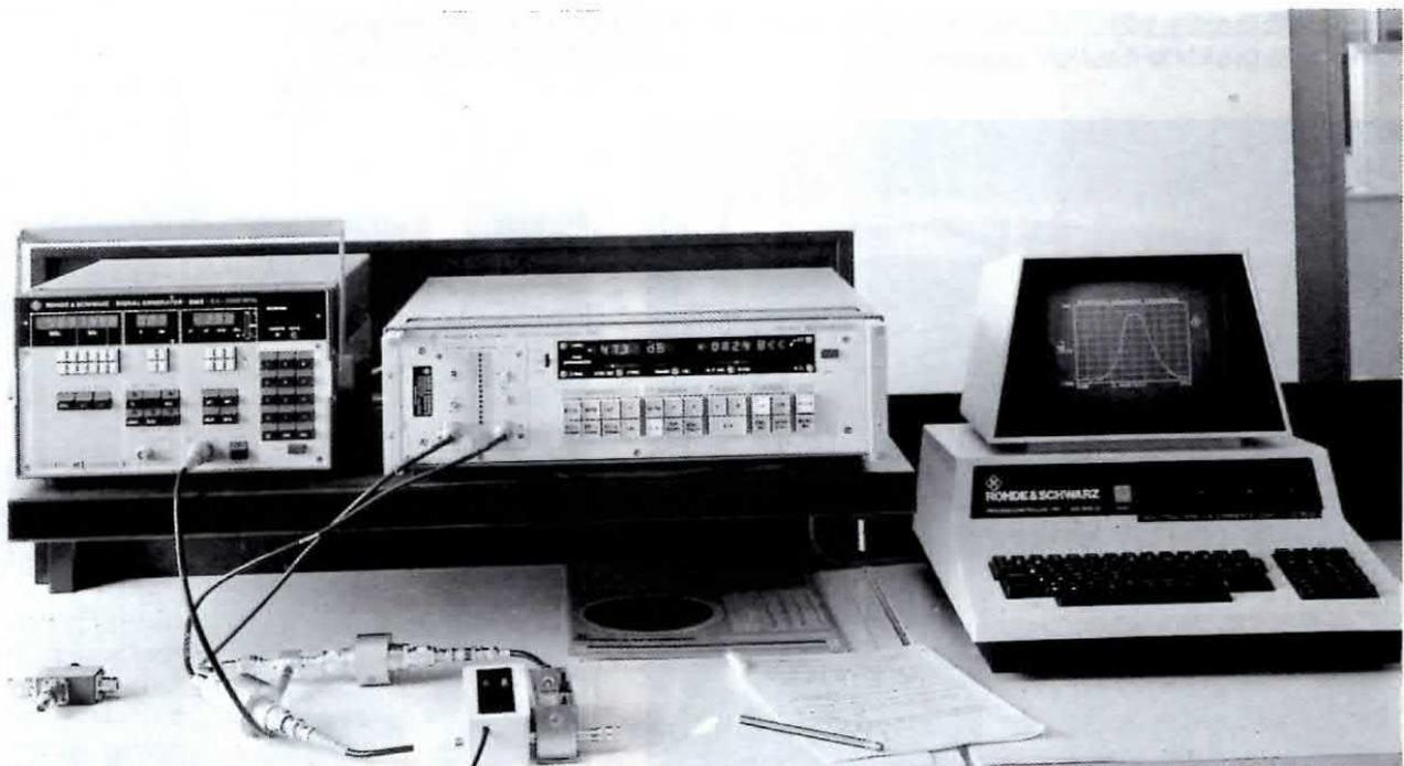
**Sul monitor del computer appaiono la curva di risposta ed il relativo guadagno dello stadio sotto controllo. Se questi dati non corrispondono alle caratteristiche richieste occorre ricontrollare il circuito e trovare quel componente che a causa della sua tolleranza non permette di ottenere la curva ricercata.**
