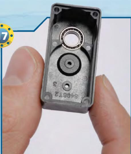
◀17▶ Posizioniamo il secondo cuscinetto a sfera nella fessura circolare presente sulla base superiore del servomotore.
